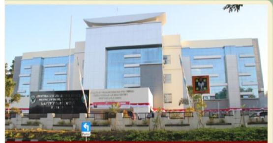
Gedung Pusat Pelayanan Jantung dan Otak Terpadu (CVBC)
